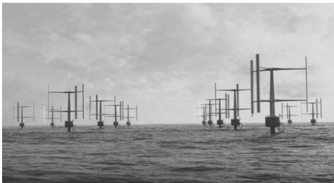
Рисунок 1.3 - Ортогональные (вертикально-осевые) ветрогенераторы.
